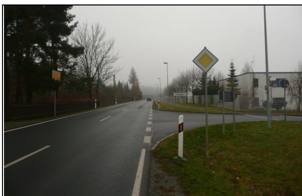
Abb. 22: Pflockenstraße (jetzt S 246) mit östlicher Zufahrt zum Gewerbegebiet (Ri. SW)
