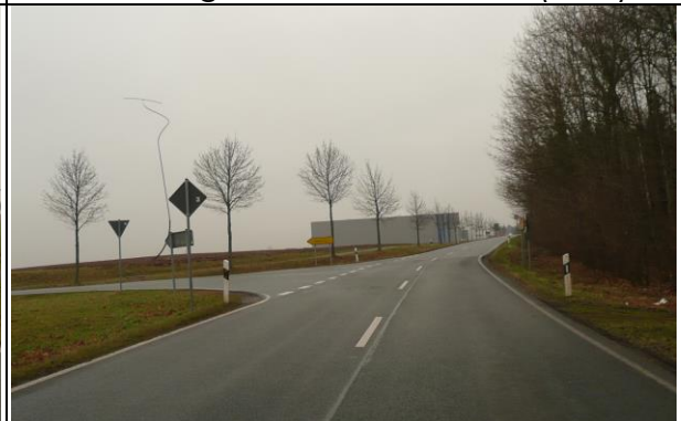
Abb. 27: Einmündung Innere Neuwieser Straße in Pflockenstraße (Ri. NO)
