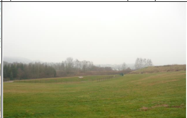
Abb. 25: Regenrückhaltebecken (Ri. N)
