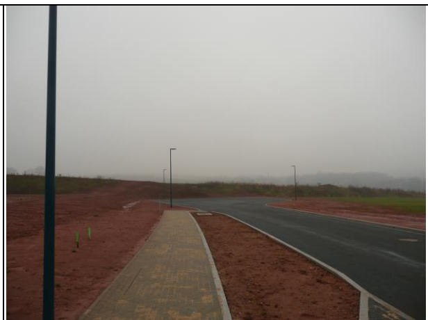
Abb. 11: Wendekreis endet vor Leitungskorridor und Böschung (Ri. SW)
