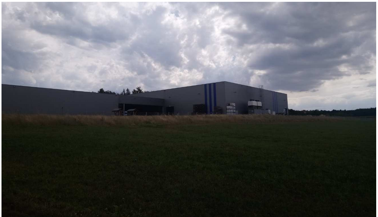
Abbildung: Betrieb der gewerblichen Vorlast im GE Hoffeld Mitte (Feintool GmbH), Hoffeldstraße 2
